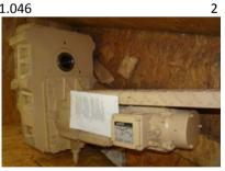
**Bauer Gearbox Motor Rappers** Type BF60 G20-04/DU08LA8W 700 RPM
